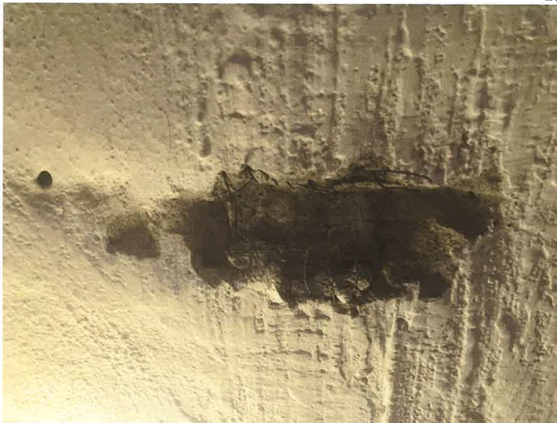
Fot.11. Odkrywka w stropie nad piwnicami, w korytarzu. Widoczna dolna stopka belki I120.
