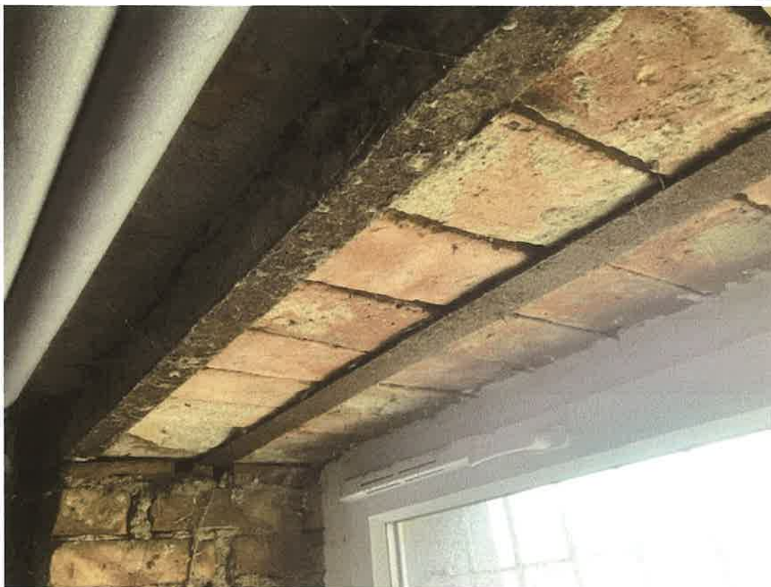
Fot.15. Stalowe nadproże okienne w piwnicach, złożone z trzech belek I120.
