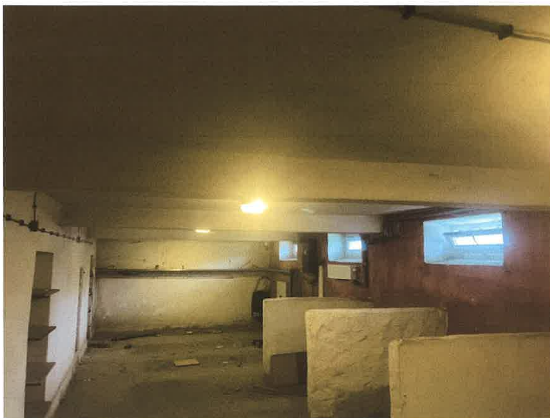
Fot.5 i 6. Strop nad piwnicą wraz z podciągami stalowymi.
