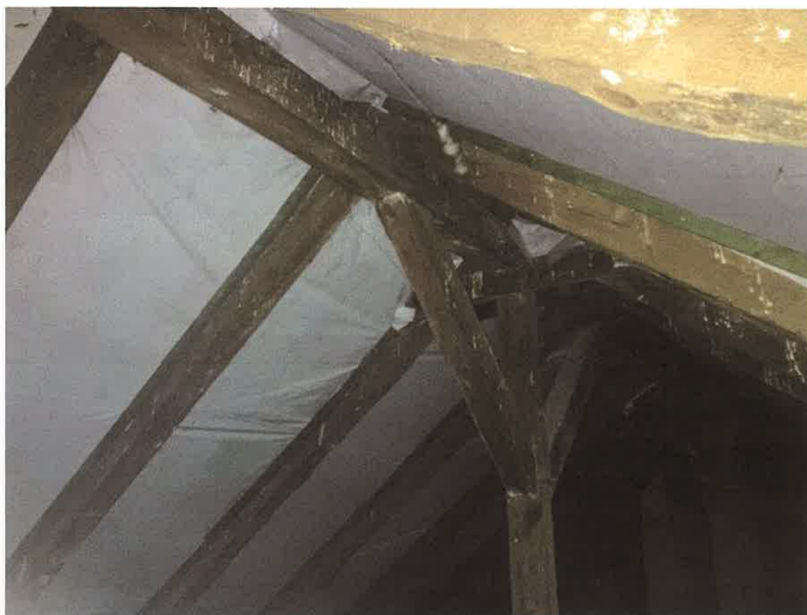
Fot.21 i 22. Drewniana więźba dachowa w lewym skrzydle budynku.
