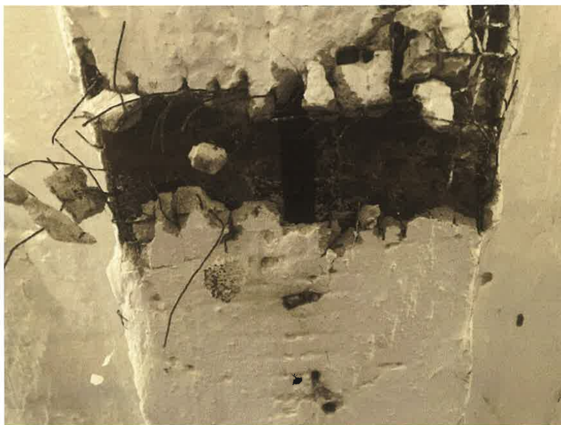
Fot.8. Odkrywka w podciągu nad piwnicami. Widoczne dolne stopki belek I160.
