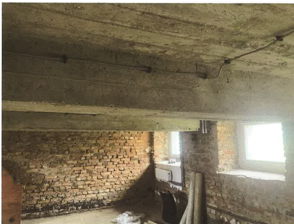
Fot.12. Widok żelbetowych podciągów i płyty stropowej w piwnicach, w lewym skrzydle budynku.
