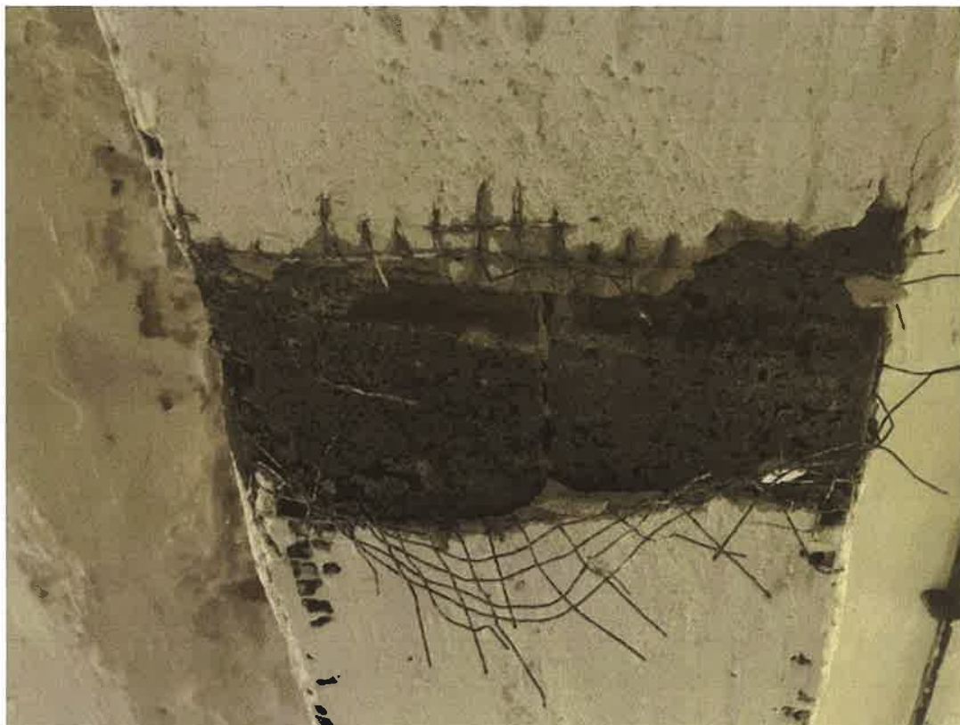
Fot.7. Odkrywka w podciągu nad piwnicami. Widoczne dolne stopki belek I240.
