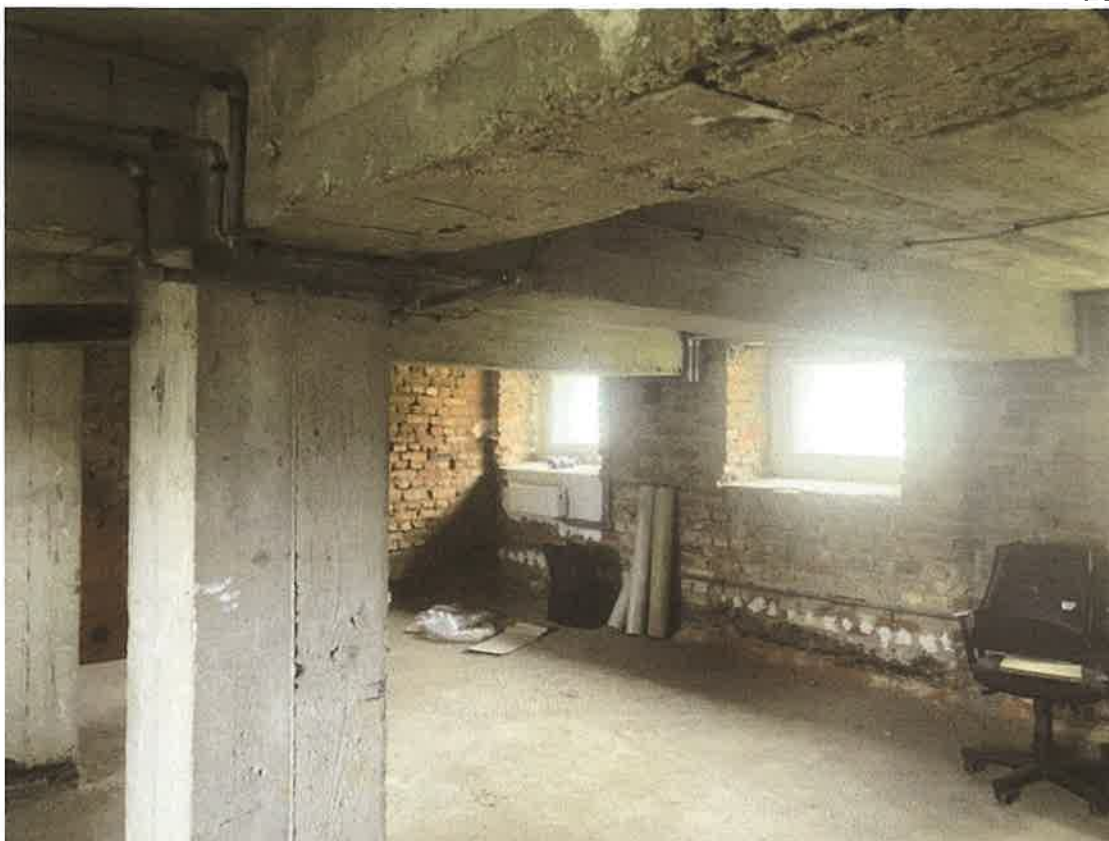
Fot.13. Widok żelbetowych podciągów i słupów w piwnicach, w lewym skrzydle budynku.
