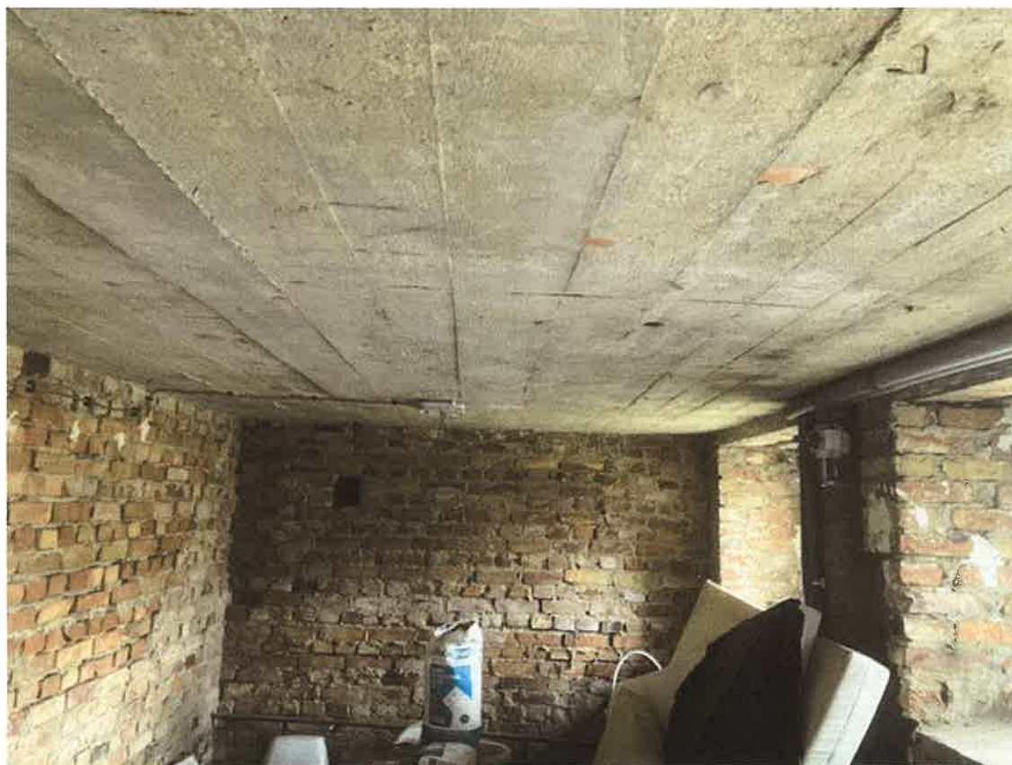
Fot.14. Żelbetowa płyta stropowa nad piwnicą w lewym skrzydle budynku.
