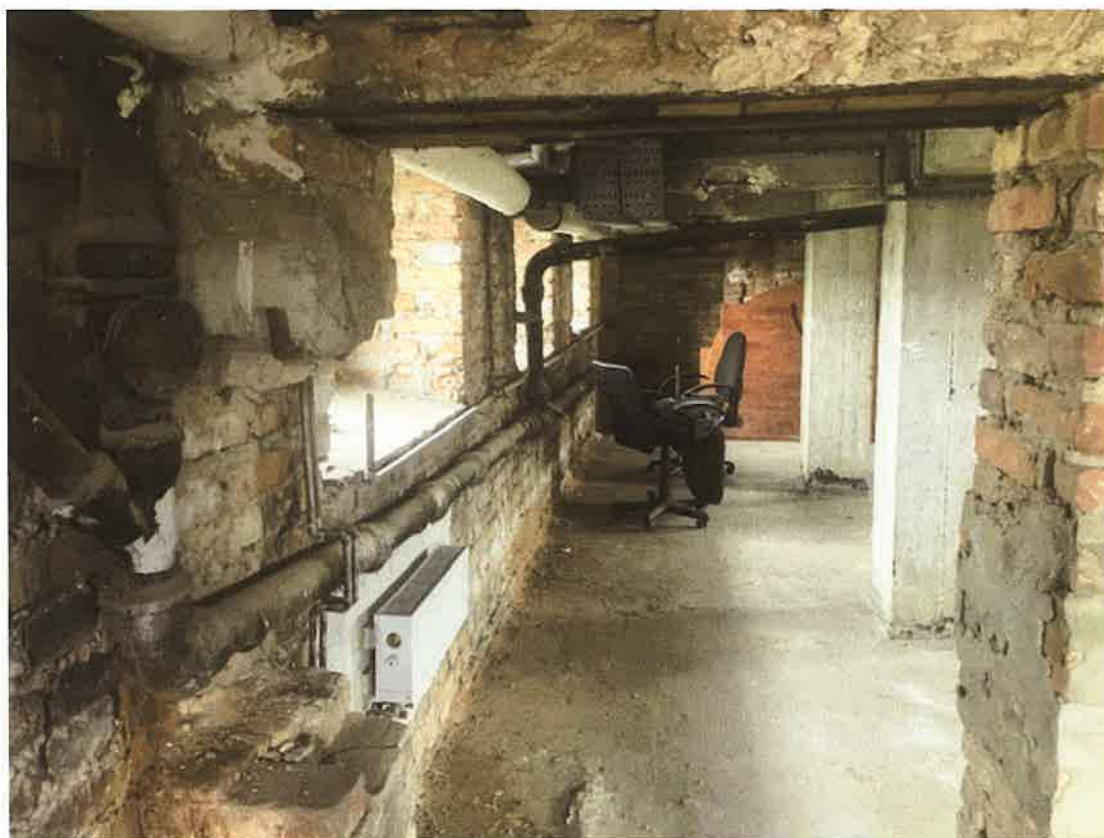
Fot.16. Rozkuty filarek w piwnicy, w lewym skrzydle budynku. Stalowe nadproże utraciło podparcie.
